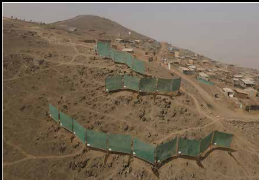
Мрежи за улавяне на питейна вода от въздуха, край Лима, Перу. От Алесандро Чинкве Fog nets installed to capture drinking water, near Lima, Peru. By Alessandro Cinque
